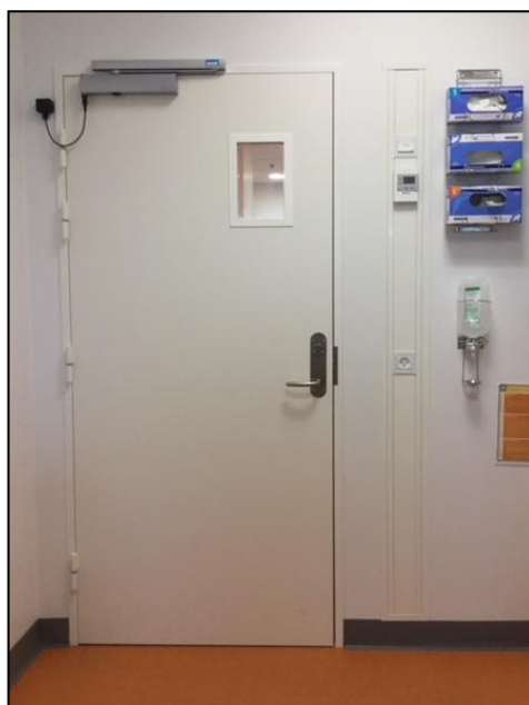
Dørpumpe monteret inde i medicinrum
